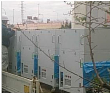
▲ 某IC・低圧発電設備の能力検証
